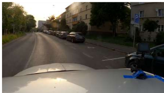
Obrázek 105: Deficit 060 - Neadekvátní provedení VDZ pro označení parkovacího pruhu
