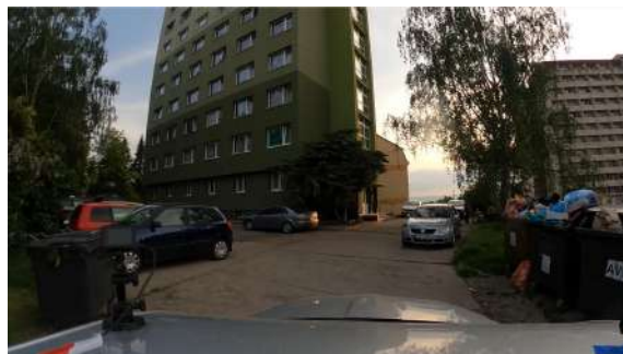
Obrázek 3: Deficit 001 - Neoznačená nástupní plocha pro požární techniku - víkend
