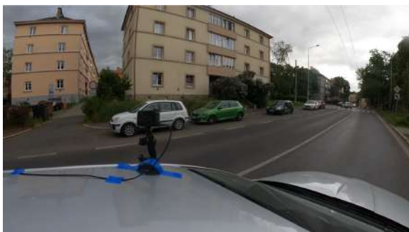
Obrázek 104: Deficit 059 - Neadekvátní provedení VDZ pro označení parkovacího pruhu
