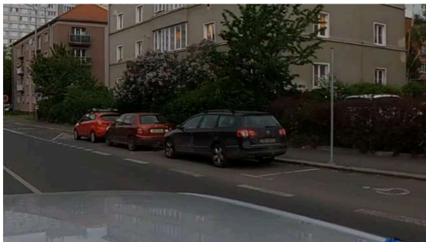
Obrázek 103: Deficit 058 - Absence SDZ nebo neadekvátně odstraněné VDZ
