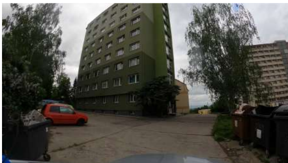
Obrázek 2: Deficit 001 - Neoznačená nástupní plocha pro požární techniku - v pracovní době všedního dne
